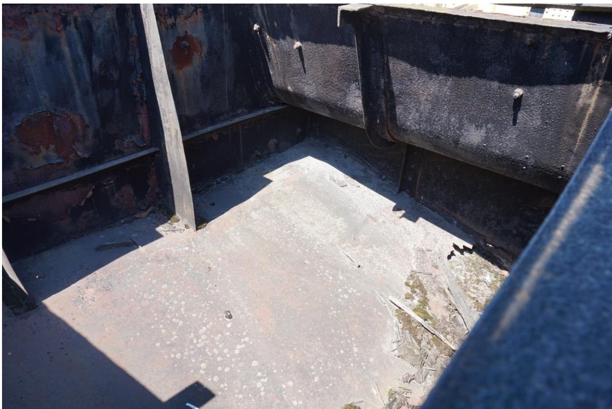
Fot. 11: wnętrze skrzyni węglowej.
