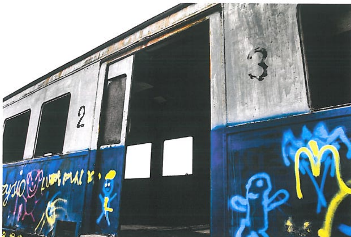
Rysunek 21: Bok EW51. Widoczne zachowane skrzydła drzwi.
