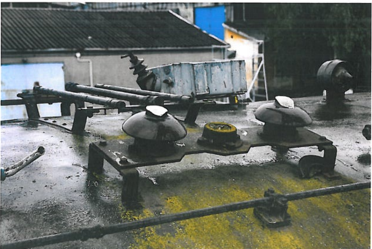
Rysunek 27: Elementy instalacji elektrycznej na dachu pojazdu.
