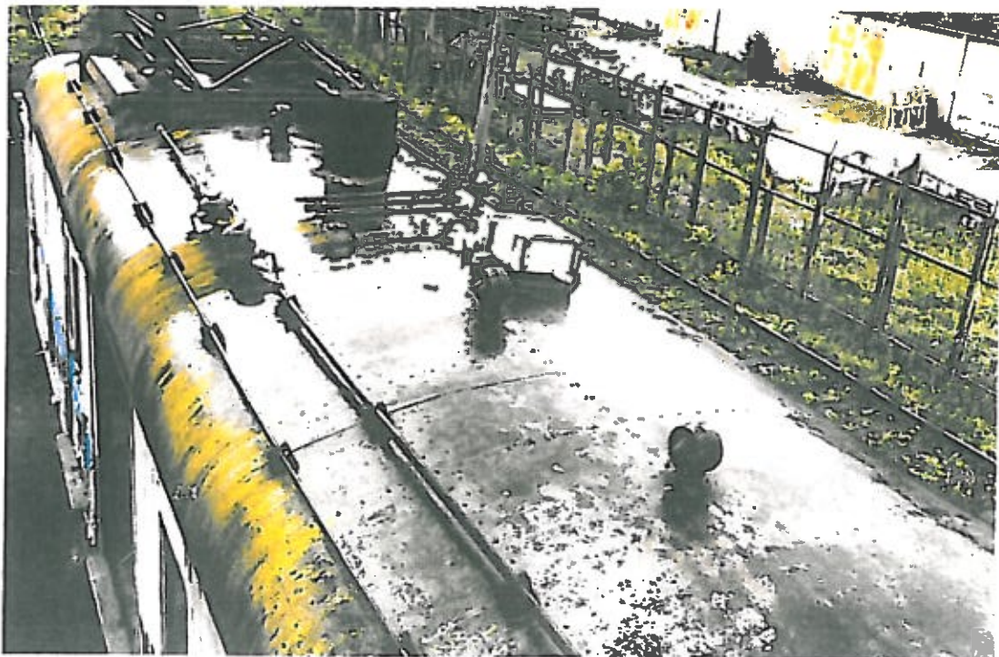
Rysunek 41. Widok na dach pojazdu (w stronę przodu). Fot. P. Ratajczyk
