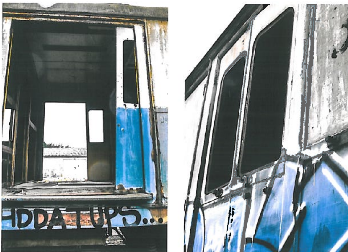
Rysunek 12: Zachowane skrzydła drzwi automatycznych (po lewej), oraz drzwi do przedziału konduktorskiego z dobrze widocznymi otworami na klamkę (po prawej).
