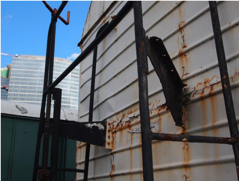
Fot. 50: Brak desek drewnianego pomostu.
