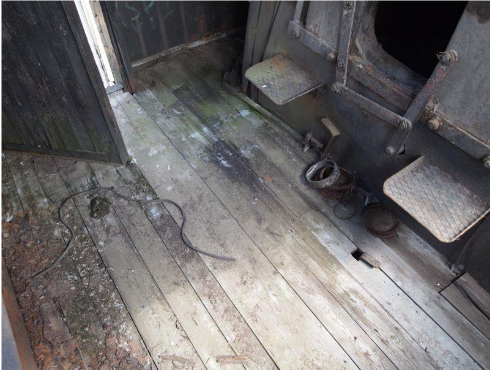
Fot. 15: Podłoga w budce maszynisty.
