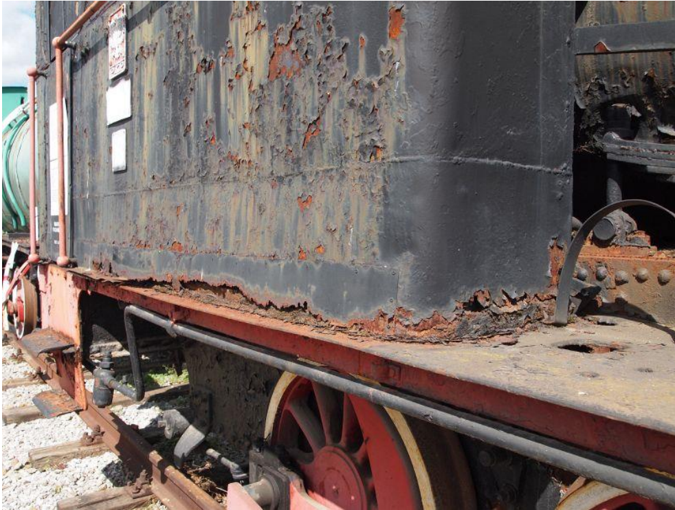
Fot. 8: Korozja i perforacje w dolnym pasie budki maszynisty.
