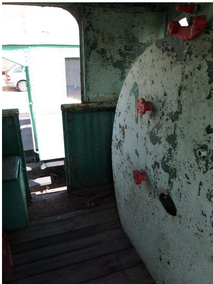
Fot. 4: Wnętrze budki maszynisty.
