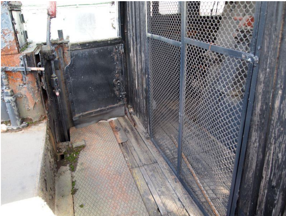
Fot. 24: Wnętrze budki maszynisty.
