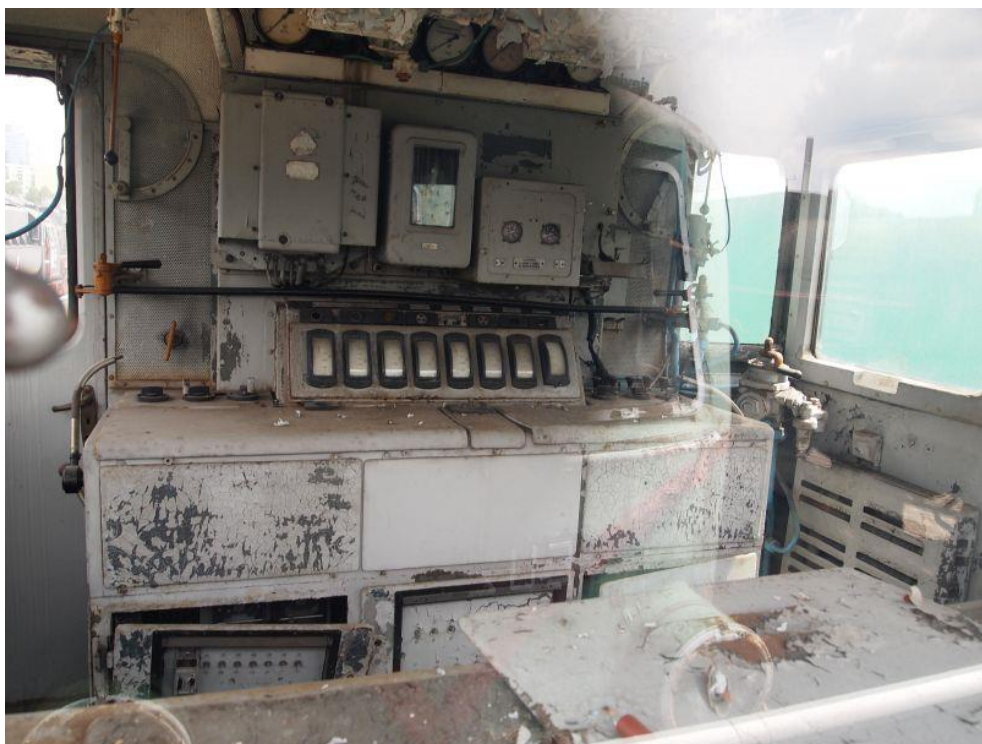
Fot. 24: wnętrze kabiny maszynisty.
