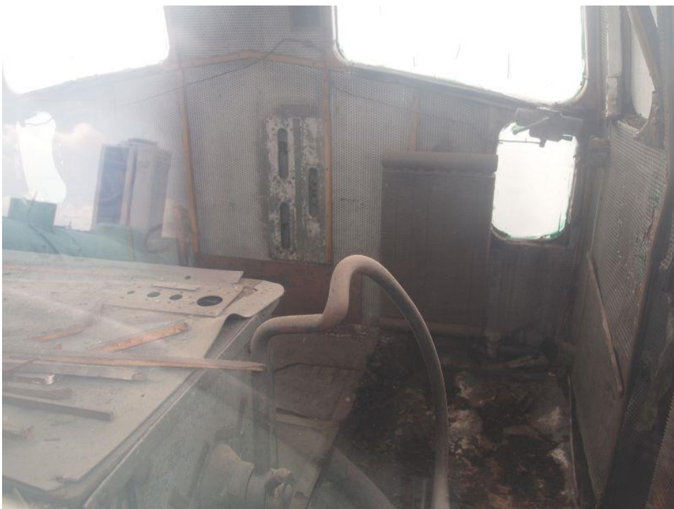
Fot. 15: Wnętrze kabiny maszynisty.
